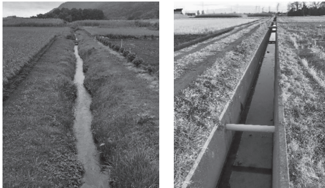
図3 土水路（左）とコンクリート水路（右）
