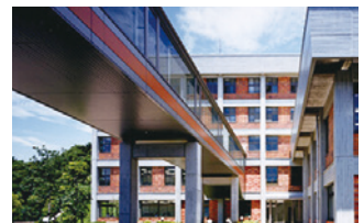
ラファエラ館増改築工事完成
